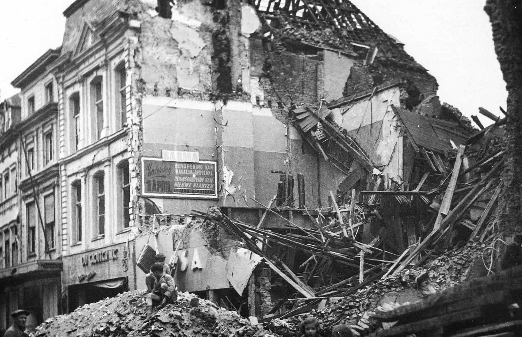
In der Leiestraat 22-24 verwüstete ein Bombeneinschlag das „Sarma“, das erste Kaufhaus von Kortrijk.
